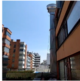
Fotografía No. 5 y 6 Ducto de descarga de la estufa y horno que operan con gas natural
