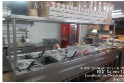
Fotografía No. 4 Línea caliente
