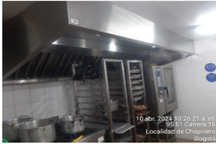
Fotografía No. 5 Campana con sistema de extracción asociado a la estufa y horno que operan con gas natural
