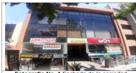
Fotografía No. 1 Fachada de la sociedad
