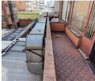
Fotografía No. 5 y 6 Ducto de descarga de la estufa y horno que operan con gas natural
